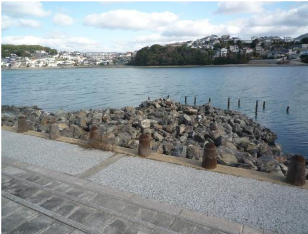
護岸は緩やかな傾斜がつけられています。
