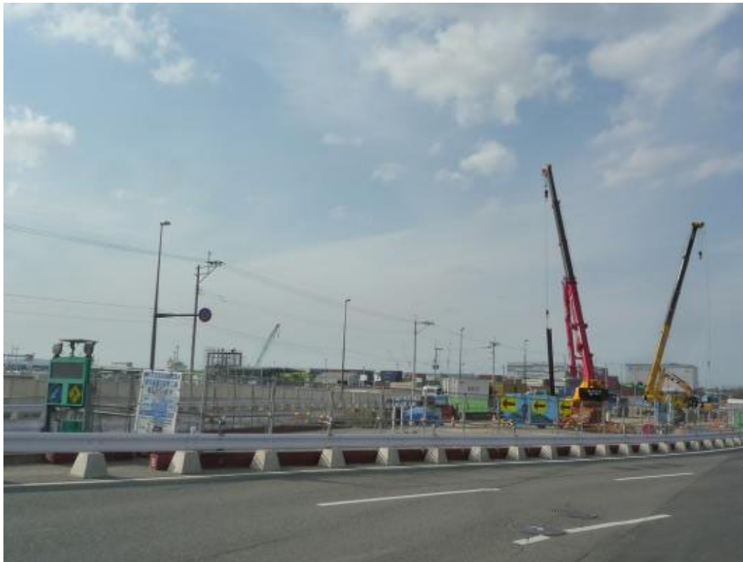
高速の出入口となるアイランドシティの道路側でも工事を行っています。
