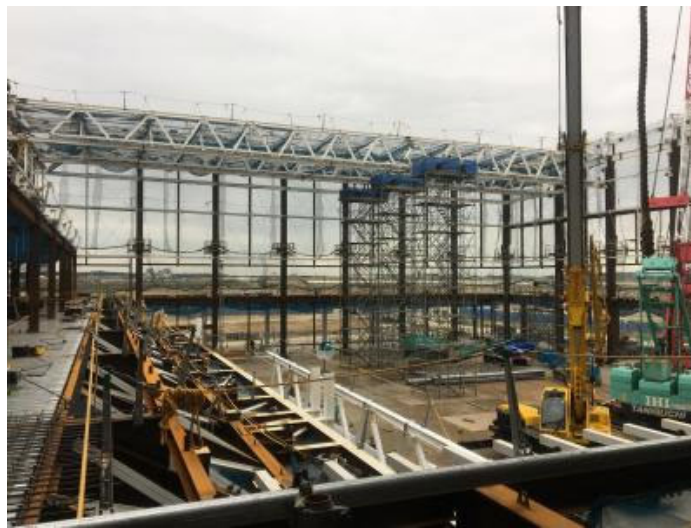
サブアリーナの写真。鉄骨の色は白です。
