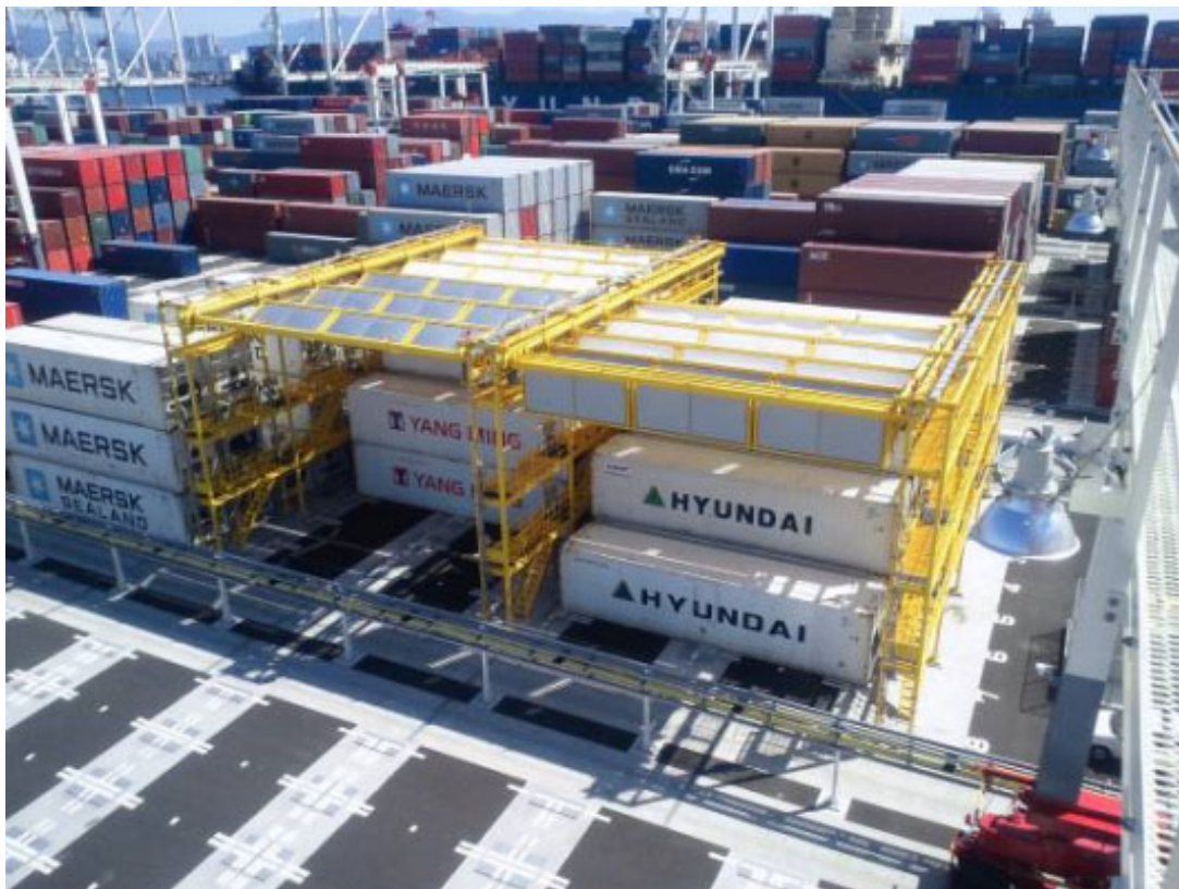
↑ルーフシェードにより冷凍・冷蔵用コンテナを直射日光から守っています！
