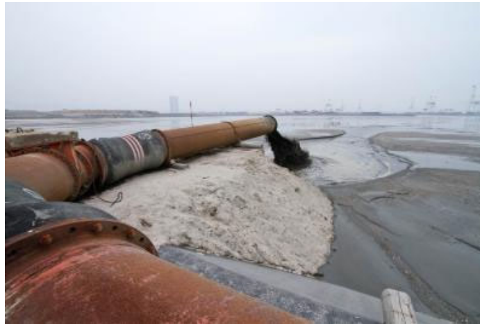
↑ 空気圧送船を使ってしゅんせつ土砂を投入しています。
