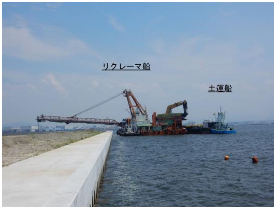
↑リクレーマ船がベルトコンベアーでアイランドシティに土を入れていきます。
