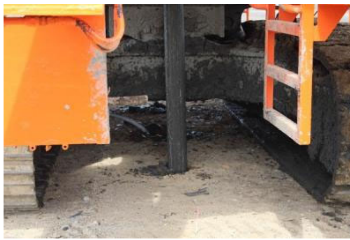
↑ドレーンを打ち込む部分はこんな感じです。
