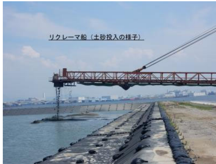
↑土運船がアイランドシティまで来て、リクレーマ船に移しかえます。
