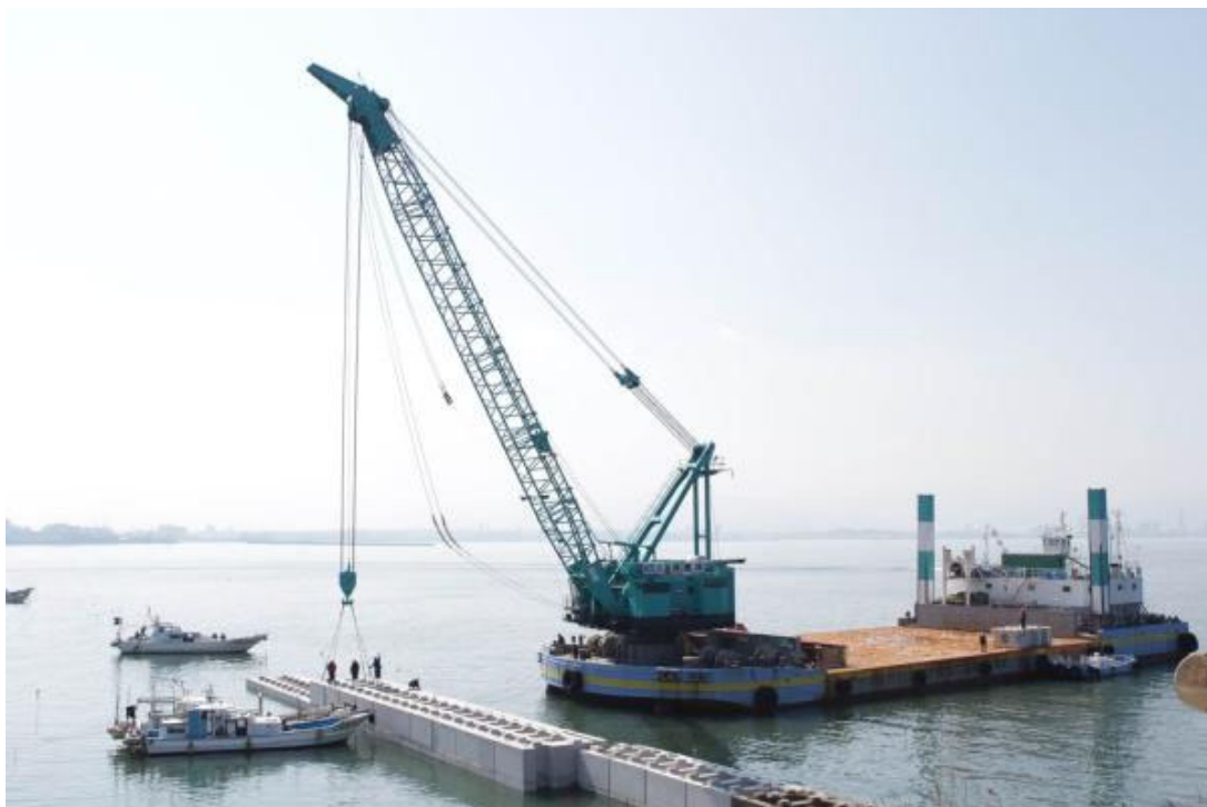
↑護岸工事の様子です。
