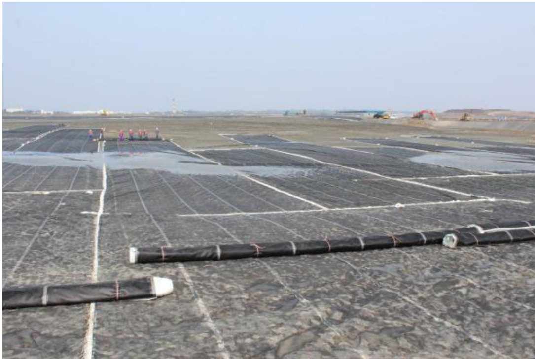
↑補強シートを敷いている様子
