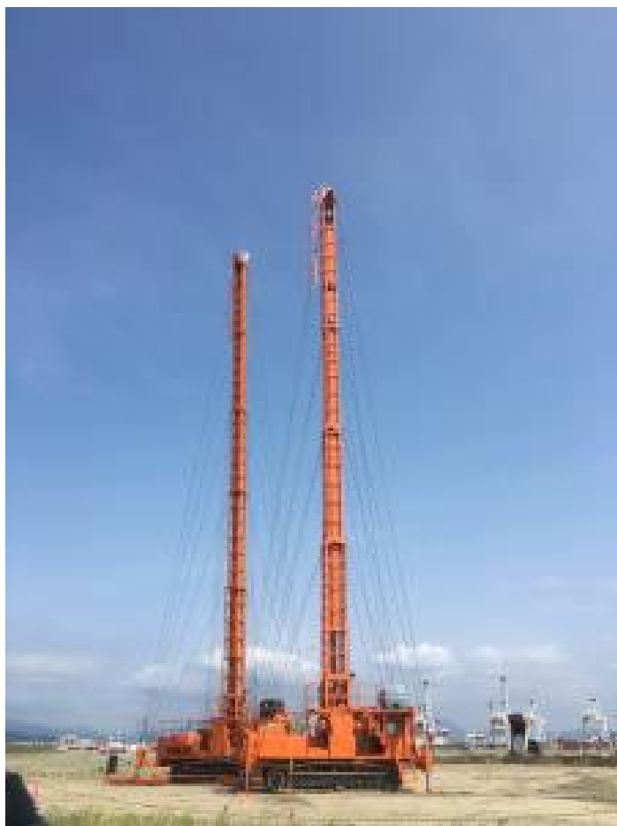
↑ドレーン打設機。高さはなんと約30m!
