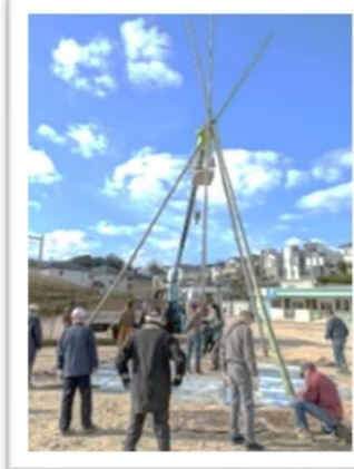
↑ 組み立て作業
