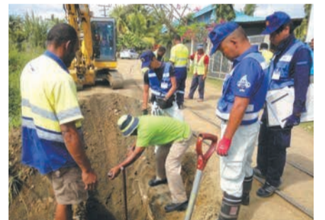
フィジー共和国の漏水率は50%以上。市は平成26年から令和4年まで、同国の給水環境の改善に取り組みました
