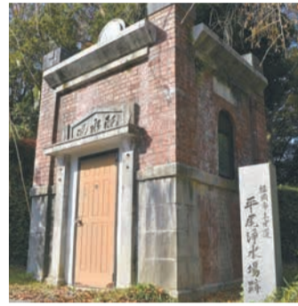
市植物園(中央区小笹五丁目)に残る平尾浄水場跡
