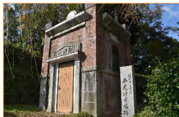
福岡市植物園に残る平尾浄水場跡
