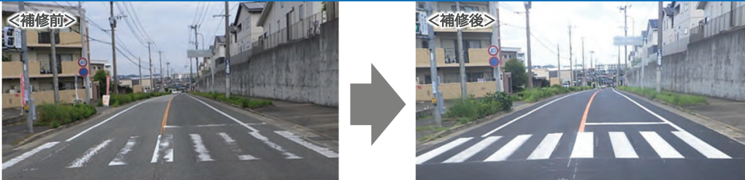
舗装補修（桧原柏原2号線）
