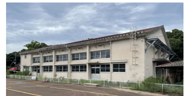
< 改修する体育館の外観 >
