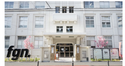
<スタートアップ支援施設
