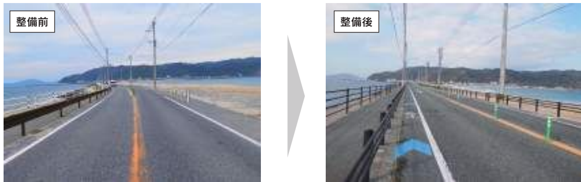
自転車通行環境の整備 (矢羽根型路面表示設置)
