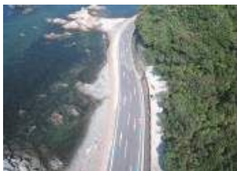
自転車通行空間整備
