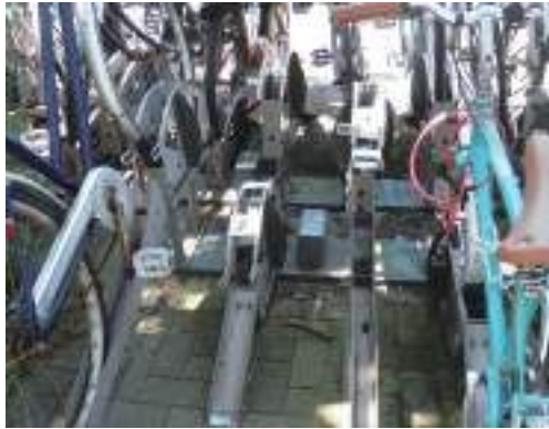
老朽化した駐輪ラック
