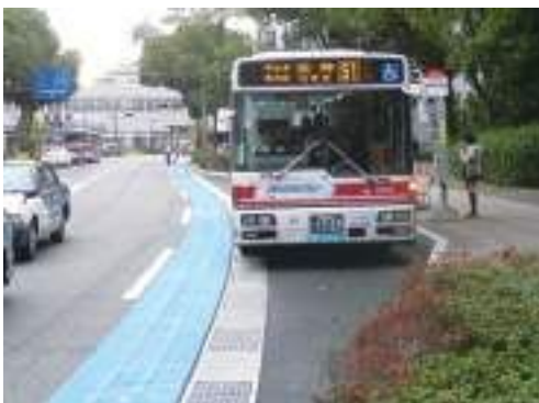
市道吉塚停車場線（平成26年度整備）
