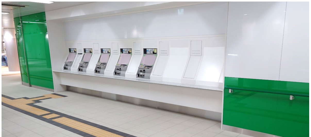
[内部の状況（駅務機器等）]
