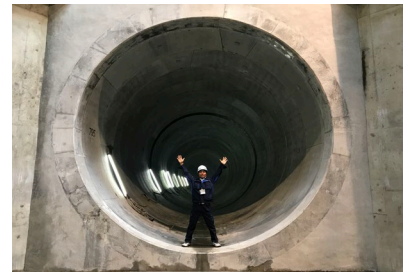
中部2号幹線(雨水貯留管)の見学
