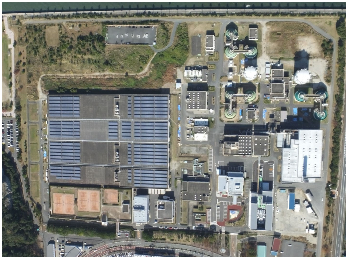
西部水処理センター航空写真
