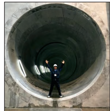
雨水管（内径5m）
