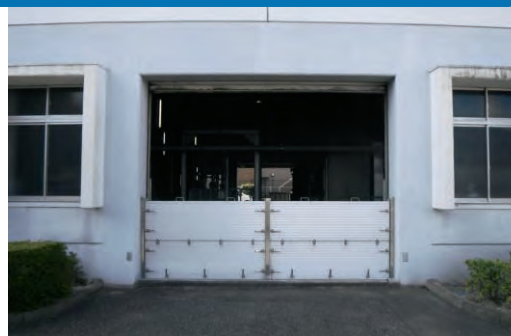
▲止水板 設置時
