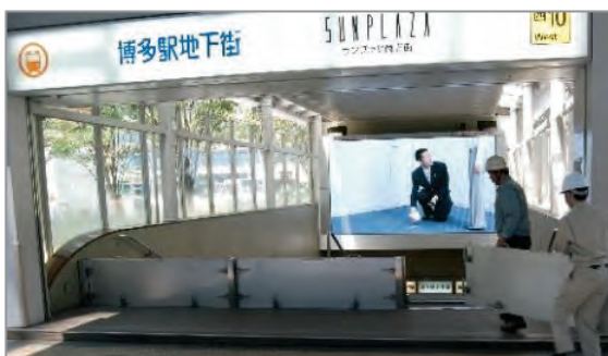
地下街管理者による止水板設置
