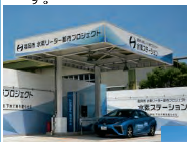
▲下水から水素をつくる世界初の水素ステーション
