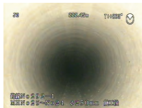
施工後（管更生）
