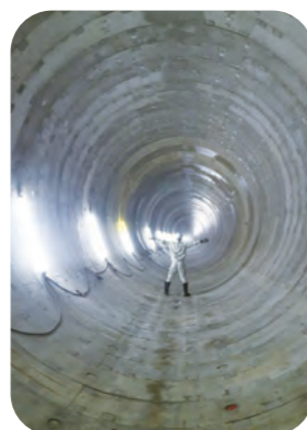
雨水貯留管（中部2号幹線）
