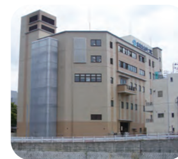
博多駅北ポンプ場
