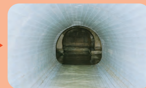
内側から修理した下水道管
