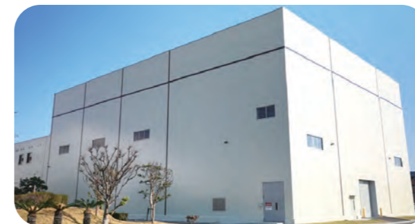
燃料化施設(西部水処理センター)
