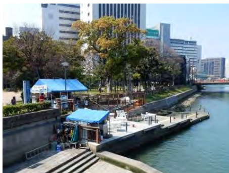
(二級河川那珂川：船着場)
