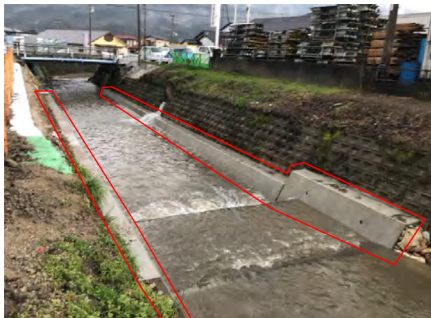
（普通河川大谷川：根継工）
