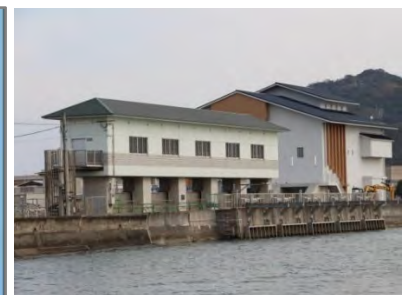
（二級河川水崎川：排水機場）
