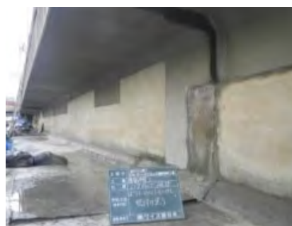
（二級河川七隈川：補修後）
