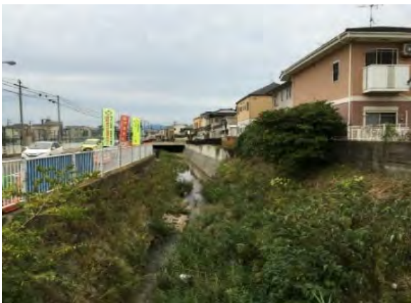
(二級河川金屑川：整備前)
