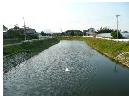
（二級河川周船寺川：整備後）
