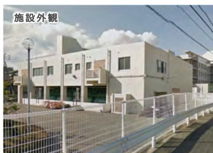
（二級河川吉塚新川排水機場）
