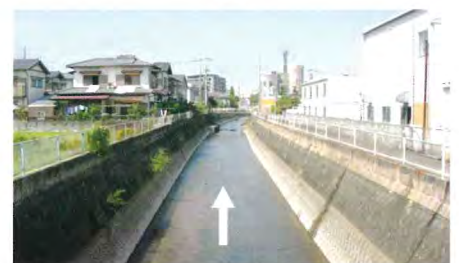
那珂古川（改修後）
