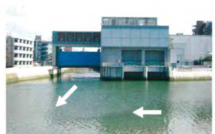
綿打川排水機場
