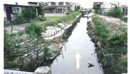
那珂古川（改修前）
