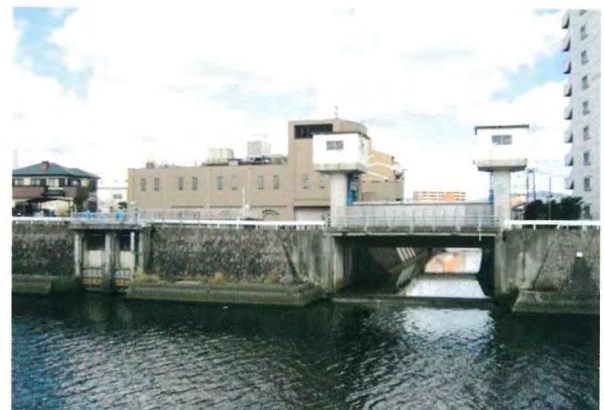
上牟田川排水機場
