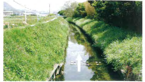
周船寺川（改修前）
