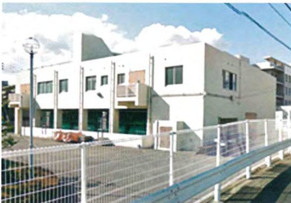
吉塚新川排水機場
