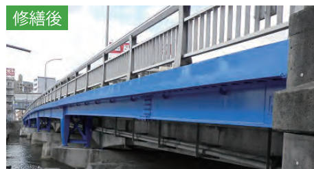
橋梁の修繕状況
