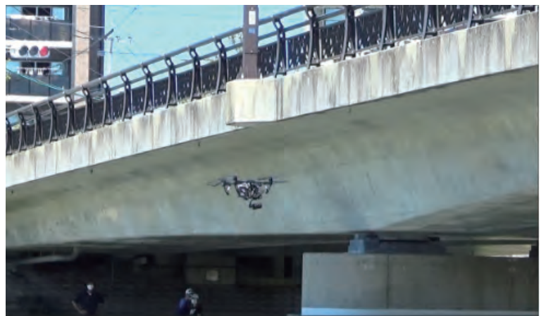
ドローンを活用した橋梁の点検状況
