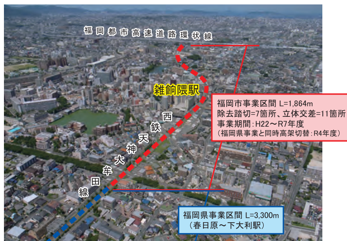
西鉄天神大牟田線連続立体交差事業（雑餉隈駅付近）
