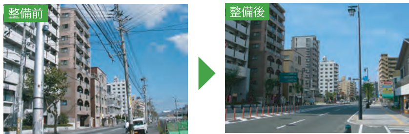
無電柱化 [都市計画道路 堅粕箱崎線]
