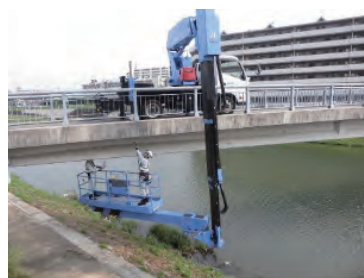
橋梁の点検状況
