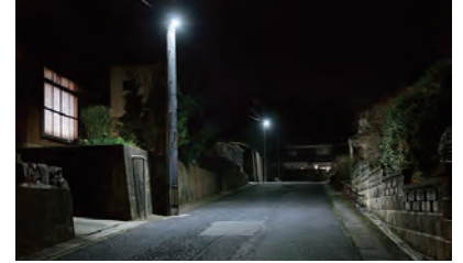
LED 防犯灯の設置例
