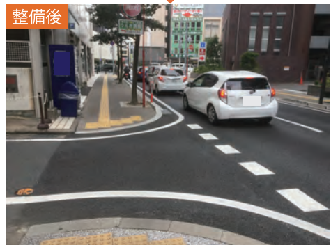
バリアフリー化された歩道
