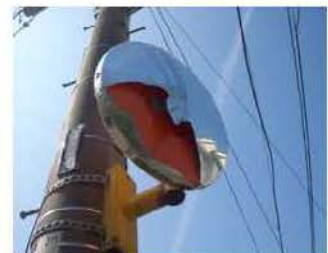
カーブミラーの破損
