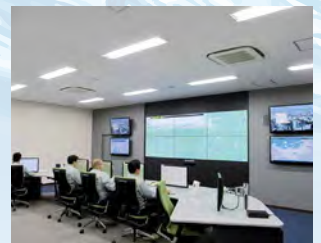
水管理センター(水道局本庁舎)
