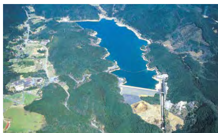
脊振ダム (那珂川水系) 供用開始: 昭和51 (1976) 年 管理: 福岡市 有効貯水容量: 4,401,000m 3
