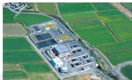
瑞梅寺浄水場 給水開始: 昭和52 (1977) 年 施設能力: 22,000m 3 /日 ※糸島市分7,000m 3 /日を含む
