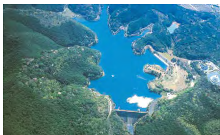
久原ダム (多々良川水系) 供用開始: 昭和46 (1971) 年 管理: 福岡市 有効貯水容量: 1,460,000m 3
