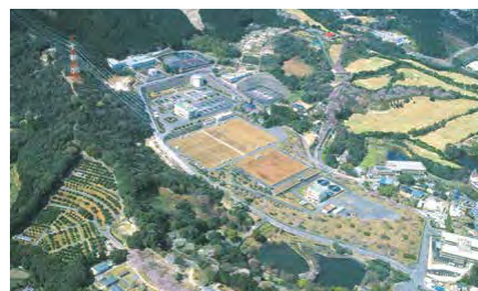
夫婦石浄水場 給水開始: 昭和51 (1976) 年 施設能力: 174,000m 3 /日
