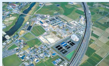
多々良浄水場 給水開始: 昭和63 (1988) 年 施設能力: 122,000m 3 /日 ※福岡地区水道企業団分22,000m 3 /日を含む
