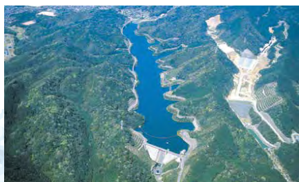
長谷ダム (多々良川水系) 供用開始: 平成5 (1993) 年 管理: 福岡市 有効貯水容量: 4,850,000m 3
