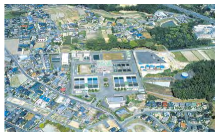
乙金浄水場 給水開始: 昭和47 (1972) 年 施設能力: 110,500m 3 /日
