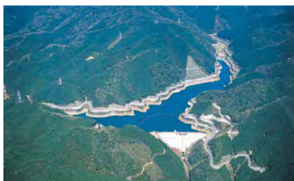
猪野ダム (多々良川水系) 供用開始: 平成13 (2001) 年 管理: 福岡県 有効貯水容量: 4,910,000m 3
