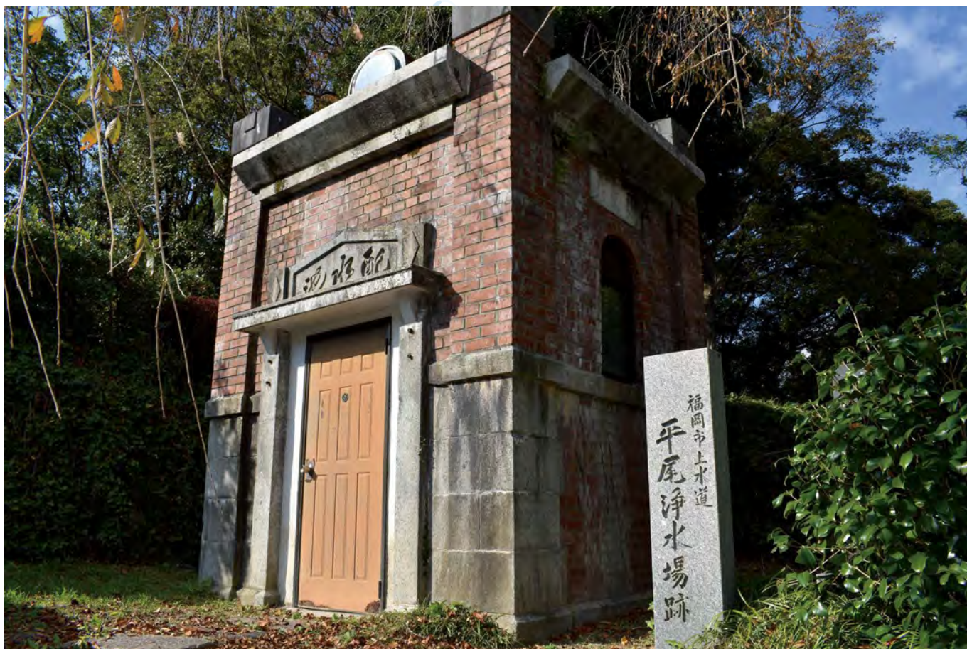
福岡市植物園に残る平尾浄水場跡（配水池の点検用通路入口）
