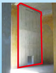
配水池への耐震壁設置
