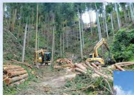
水源かん養機能を高めるための間伐作業
