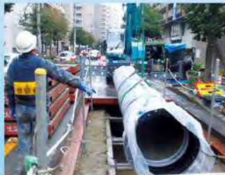
耐震管への計画的な取替え
