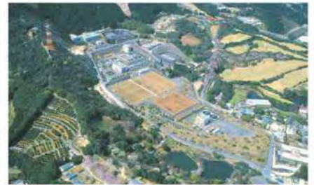
夫婦石浄水場 給水開始: 昭和51 (1976) 年 施設能力: 174,000m 3 /日
