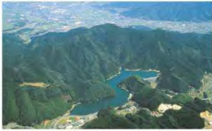
曲淵ダム (室見川水系) 供用開始: 大正12 (1923) 年 管理: 福岡市 有効貯水容量: 2,368,000m 3
