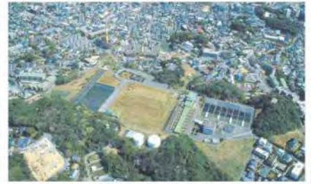
高宮浄水場 給水開始: 昭和35 (1960) 年 施設能力: 199,000m 3 /日
