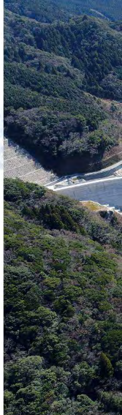
五ヶ山ダム (平成30年3月 福岡県撮影)
