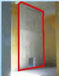
配水池への耐震壁設置
