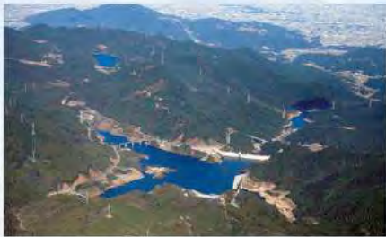
五ヶ山ダム (那珂川水系) 供用開始: 令和3 (2021) 年 管理: 福岡県 有効貯水容量: 39,700,000m 3
