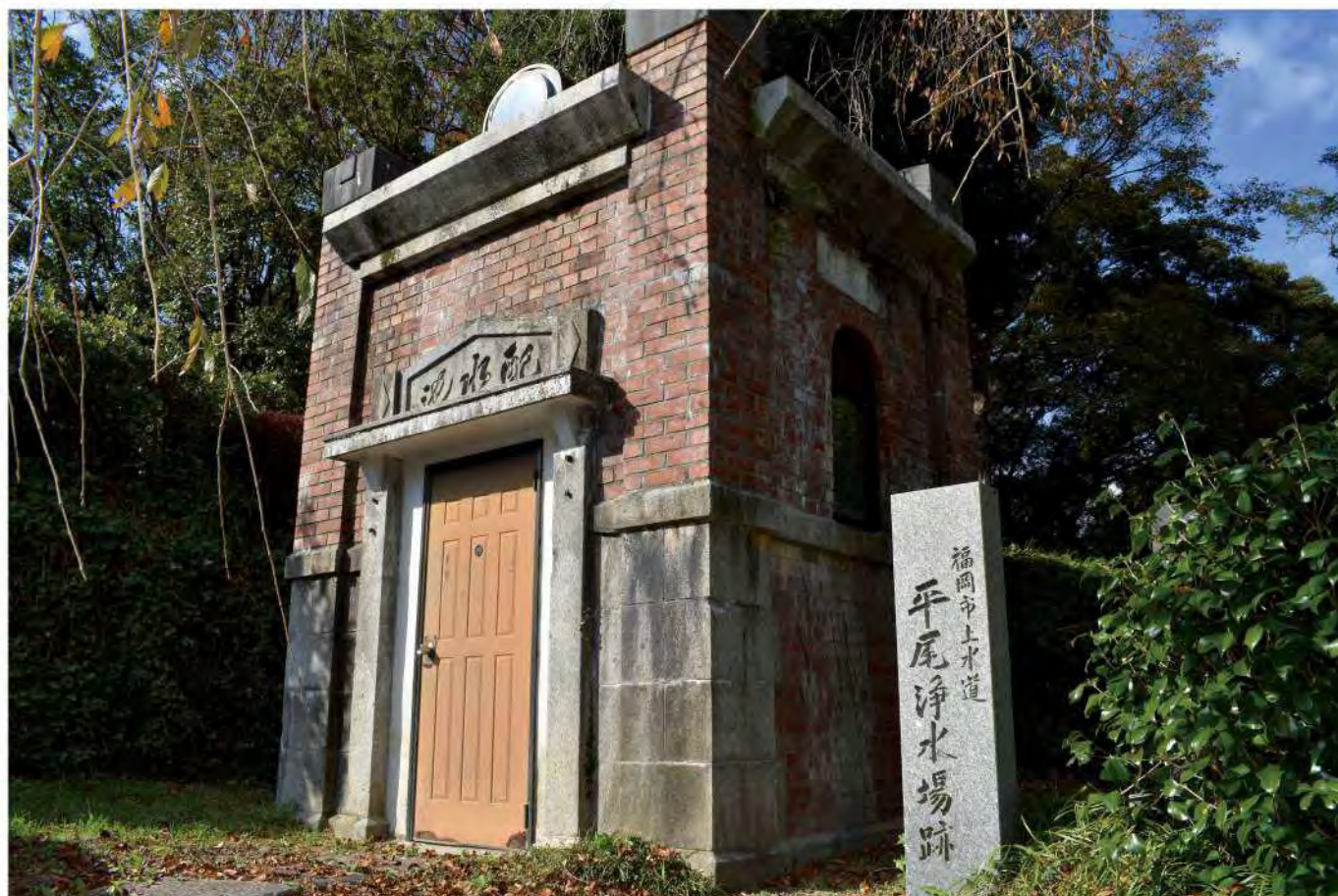
福岡市植物園に残る平尾浄水場跡（配水池の点検用通路入口）
