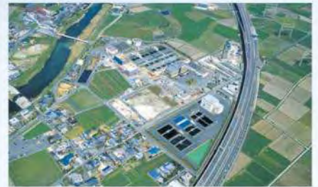
多々良浄水場 給水開始: 昭和63 (1988) 年 施設能力: 122,000m 3 /日 ※福岡地区水道企業団分22,000m 3 /日を含む
