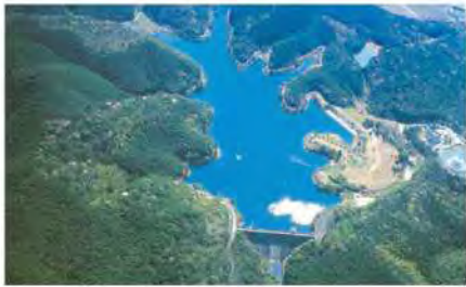
久原ダム (多々良川水系) 供用開始: 昭和46 (1971) 年 管理: 福岡市 有効貯水容量: 1,460,000m 3
