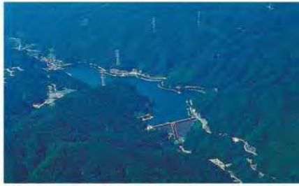
南畑ダム (那珂川水系) 供用開始: 昭和41 (1966) 年 管理: 福岡県 有効貯水容量: 5,560,000m 3
