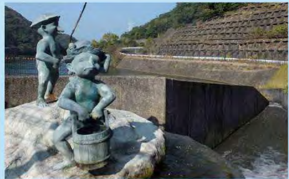
下流の河川からポンプアップした水の吹き出し口(写真は長谷ダム)
