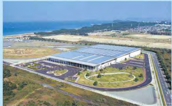
海の中道奈多海水淡水化センター(愛称:まみずピア)
