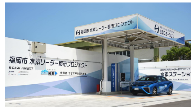
下水バイオガス由来水素ステーション （リニューアル予定）
