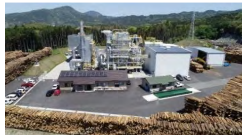
▲ ふくおか木質バイオマス発電所
