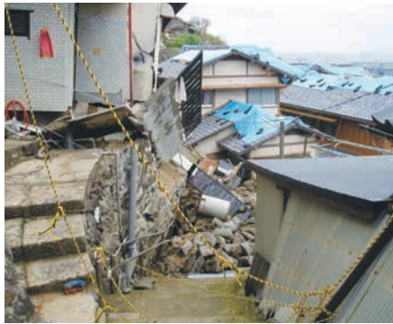
玄界島の山の斜面に建つ住宅。地震で多くの石積み土台が崩れた
