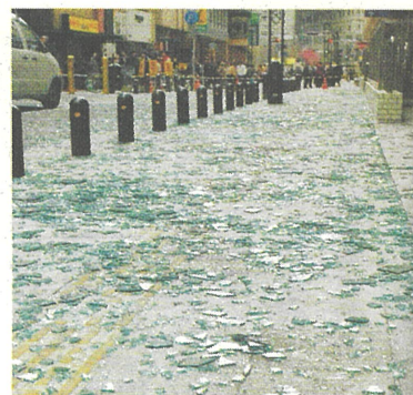
ガラスの破損落下(中央区天神一丁目)
