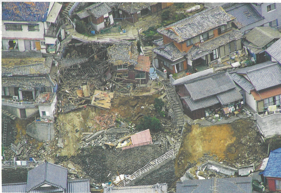
倒壊した家屋(西区玄界島)
