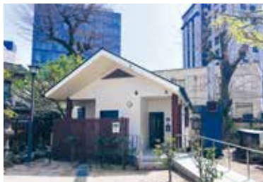
〈観光地のトイレ整備〉
