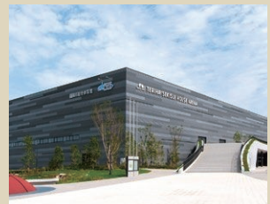
福岡市総合体育館
