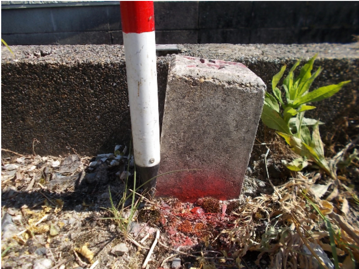
【設置前】境界点近景写真 ポイント番号：K12 既設福岡市コンクリート杭 令和7年8月1日撮影
