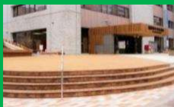
(R3年度事例) 区役所の玄関前広場に木製 デッキを整備（中央区役所）
