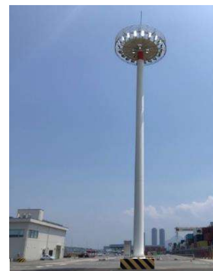
コンテナヤード照明のLED化
