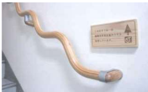
早良区役所階段手すり
