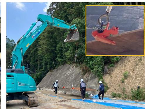
既設遮水シート損傷防止のための水平吊金具使用
