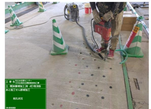
あと施工せん断補強筋 削孔状況
