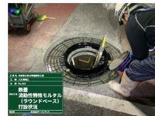
GMR工法による鉄蓋取替状況
