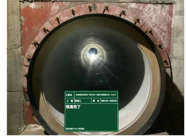
▲工事完了（地下部：管きょ工）
