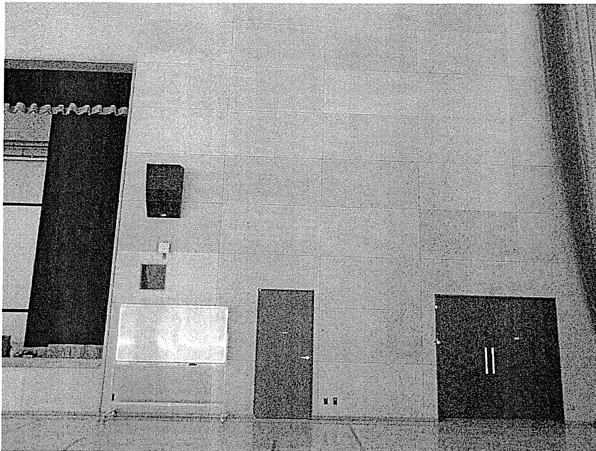
【体育館壁面の写真】
