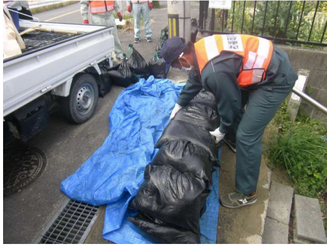
浸水防止の土のう積み
