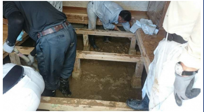
泥やゴミ等の片付作業
