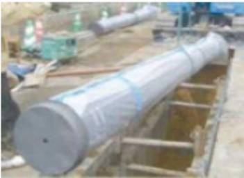
福岡市では、昭和54(1979)年度以降に埋設された管には、全国に先駆けて腐食対策としてポリエチレンスリーブを装着しています。
