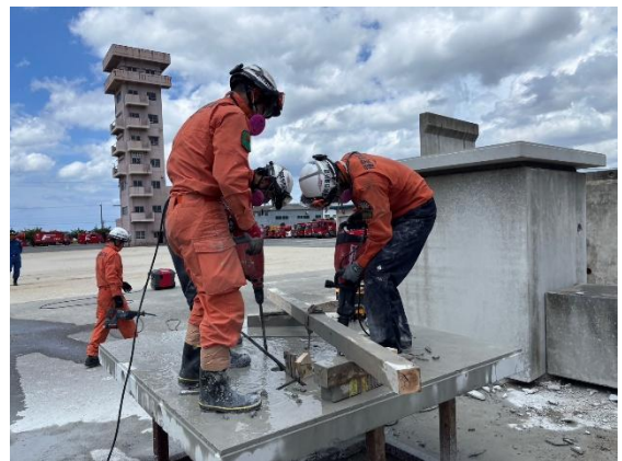
破壊用器具を使用し 倒壊した建物内の要救助者を救出する訓練
