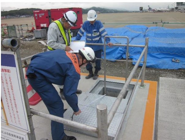
危険物施設の完成検査
