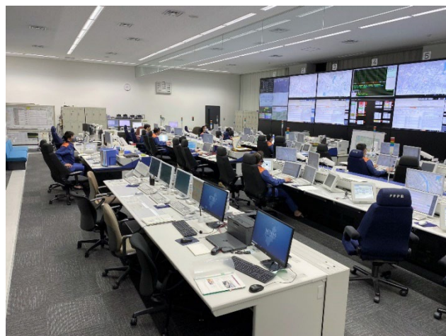
福岡都市圏消防共同指令センター
