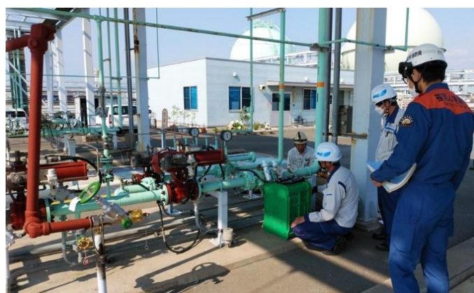
高圧ガス施設の完成検査
