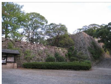
写真 4-12: 樹木整理前の天守台石垣
