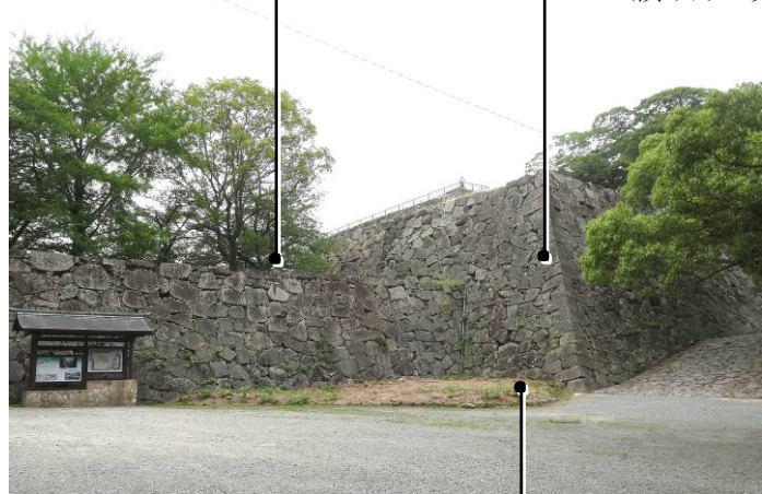
写真 4-13: 樹木整理後の天守台石垣
