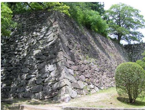
写真 2-71: [23] 東三階櫓跡・天目櫓跡方向を見る 重厚な石垣を間近に見ることができる。
