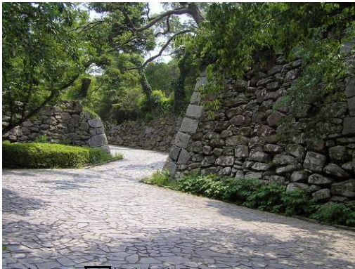
写真 2-67: [19] 桐木坂を見る 石垣と鍵型の出入口で構成される景観を見ることができる。
