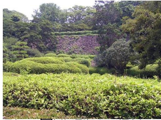
写真 2-66: [18] 舞鶴公園線よりツツジ園方向 横方向に連続する石垣が、繁茂する樹林に遮蔽され、部分的にしか見ることができない。
