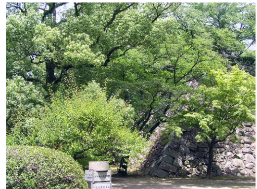
写真 2-70: [22] 西三階櫓跡・生捕櫓跡方向を見る 繁茂する樹林が、複雑に入り組み石垣を遮蔽し見えづらい。
