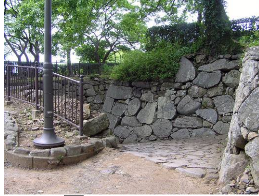
写真 2-82: [34] 武具櫓御門跡を見る 石垣を間近に見ることができる。
