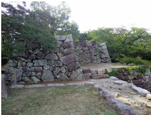
写真 2-85: [37] 小天守台を見る 小天守台～天守台への形状を間近に見ることができるが樹木が視線を遮蔽する。
