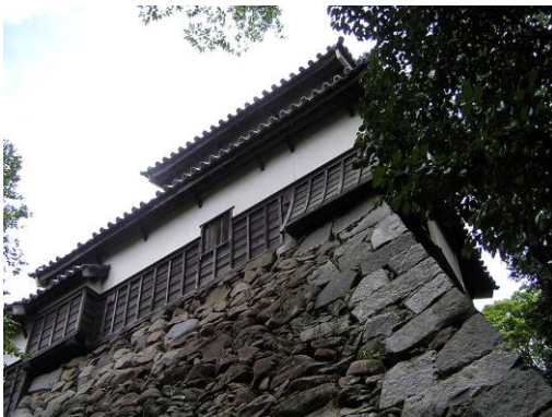
写真 2-69: [21] 多聞櫓(西角櫓)を見る 重要文化財の多聞櫓の西角櫓を間近で見上げることができる。
