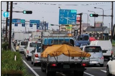
新二又瀬橋交差点（上り）
