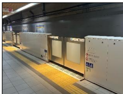
ホームドアの設置
