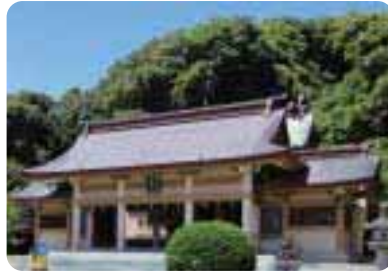
▲ てるも 光雲神社。号砲は本殿裏にある荒津山の山頂に設置されたという
