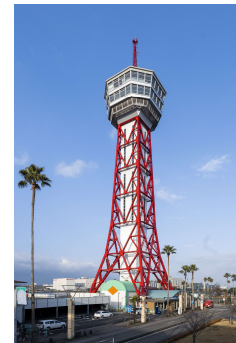
現在の博多ポートタワー
