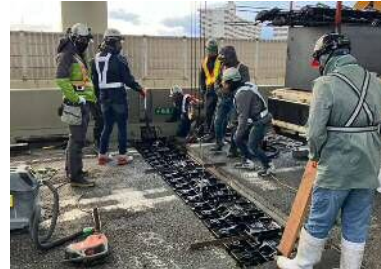
《伸縮継手取替》
