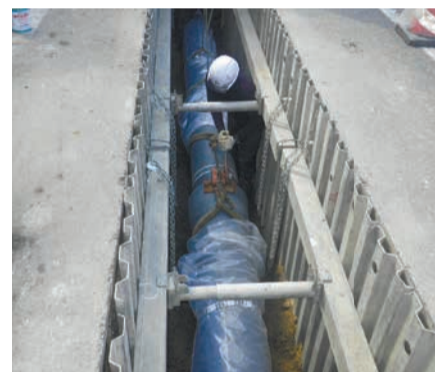
配水管の敷設工事
