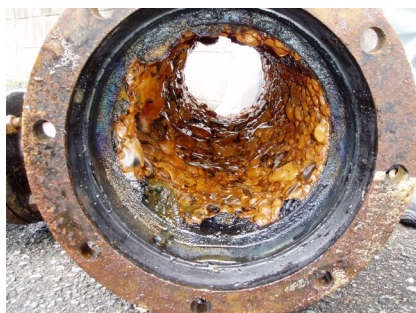
昭和44（1969）年に布設された水道管
