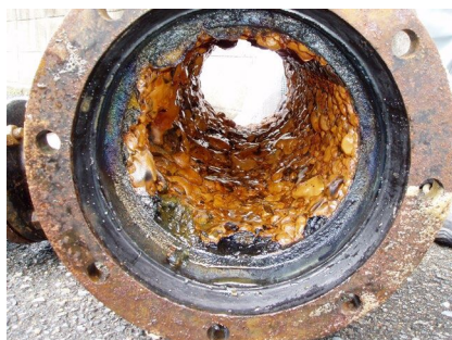
昭和44(1969)年に布設された水道管
