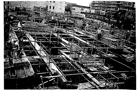
6. 基礎工事施工状況（平成9年12月1日）
