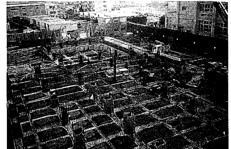
7. 土工事埋め戻し状況（平成9年12月29日）
