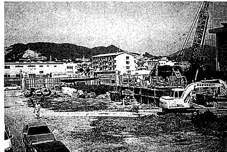
2. コンクリート杭打設状況（平成9年7月31日）
