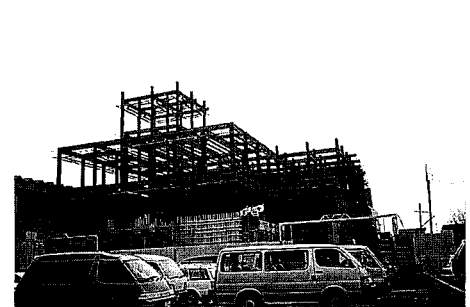
9. 一階型枠建て込み状況（平成10年2月28日）
