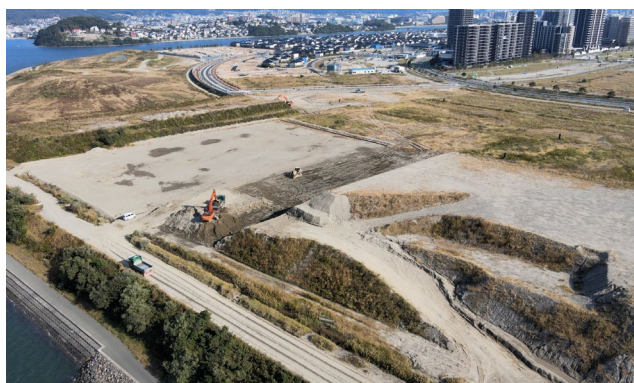
二次覆土撤去（市5の3工区）
