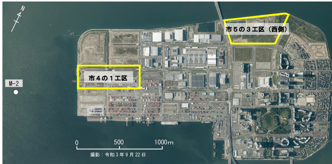
図3 監視地点、監視対象工事箇所
