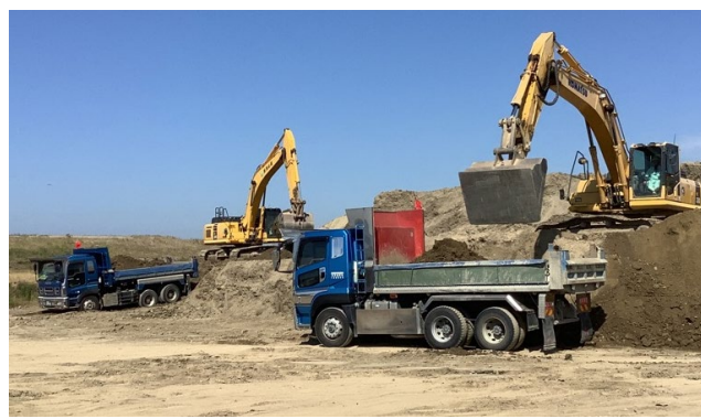
二次覆土撤去（市4の1工区）
