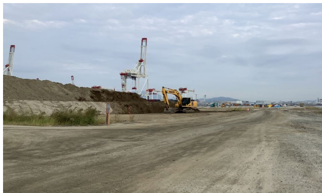
二次覆土撤去（市4の1工区）
