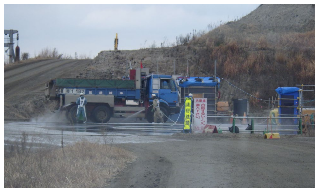
車両洗淨施設
