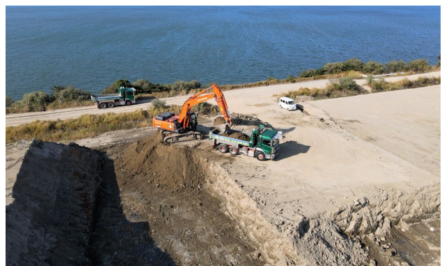
二次覆土撤去（市5の3工区）
